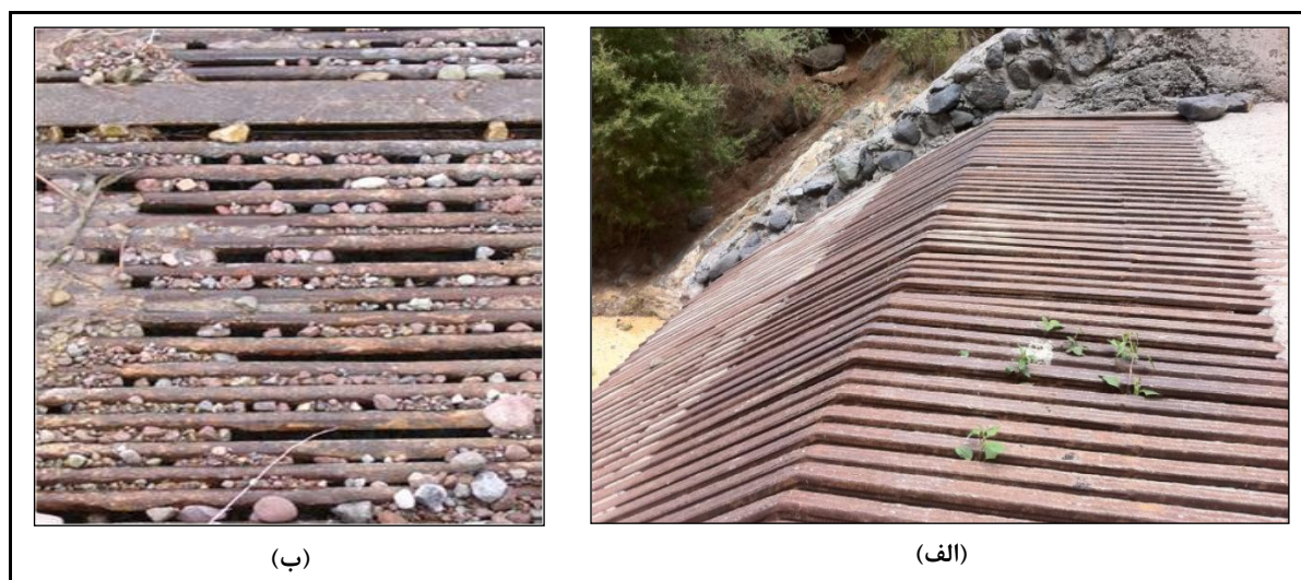
شکل ۱- الف) آبیگر کفی با میله‌های مشبک (Castillo et al., 2016) و ب) گرفتگی مشبکها
