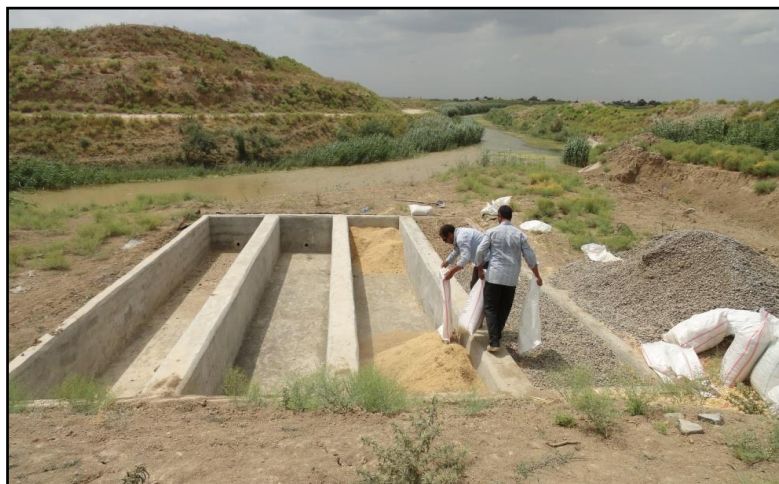
شکل ۱- پر کردن حوضچه‌ها با فیلتر (سبوس برنج)
