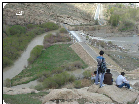
شکل ۱- نمونه‌های احداث سرریزها در محدوده پیچ رودخانه، (الف) سد انحرافی در پیچ رودخانه نازلو، ارومیه و (ب) سرریز در پیچ رودخانه قون، فرانسه
