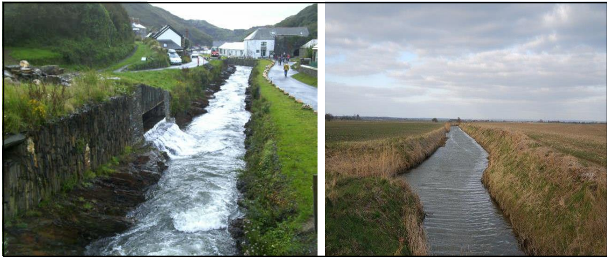
شکل ۱- راست) تلاقی یک کانال زهکش با کانال هاینوک ۱ چپ) تلاقی یک کانال شهری (با بستر صلب و اختلاف تراز کف) با کانال طبیعی
