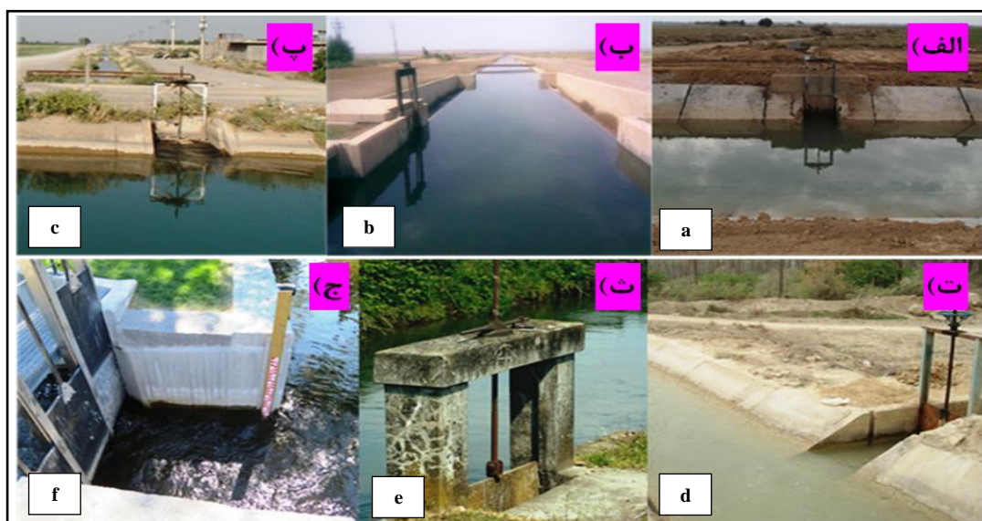
شکل ۱- نمایی از کاربرد گسترده دریچه کشویی جانبی در شبکه‌های آبیاری و زهکشی. (الف) شبکه آبیاری و زهکشی شاوور خوزستان، (ب) شبکه آبیاری و زهکشی ساوه مرکزی، (پ) شبکه آبیاری و زهکشی میاندر کرمانشاه، (ت) شبکه آبیاری و زهکشی دالکی بوشهر، (ث) کاربرد دریچه کشویی برای آبیاری مزارع برنج و (ج) شبکه آبیاری در سوئد (Noorköping, Sweden).
