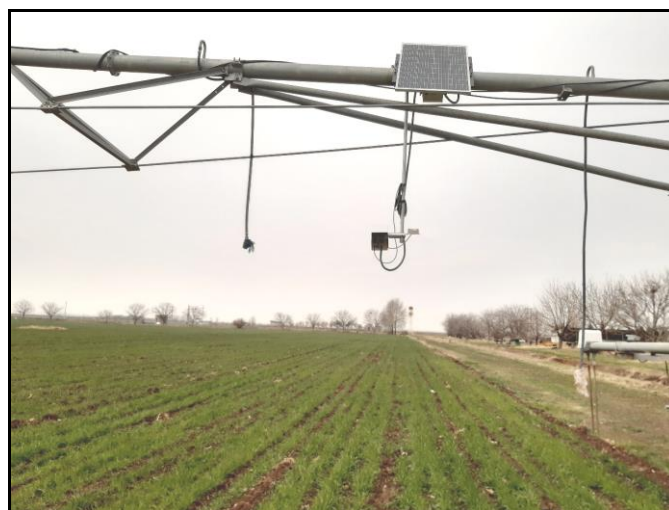
شکل ۱- نمایی از یک سامانه پایش خودکار نصب شده روی سامانه آبیاری لاینر (ایستگاه تحقیقاتی اسماعیل آباد، قزوین)
