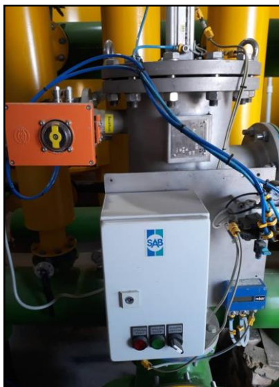
شکل ۷- نمونه‌ای از به‌کارگیری سامانه اسکادا برای مدیریت آبیاری در سطح باغ‌های انگور (تاکستان، قزوین)
