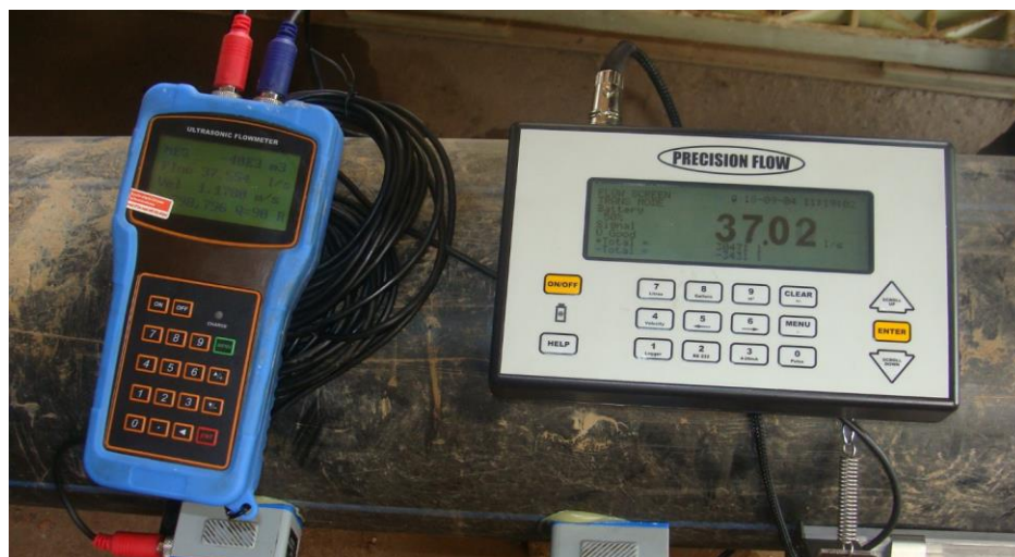
شکل ۱- پایش دبی در محل ایستگاه پمپاژ با استفاده از دبی سنچ اولتراسونیک
