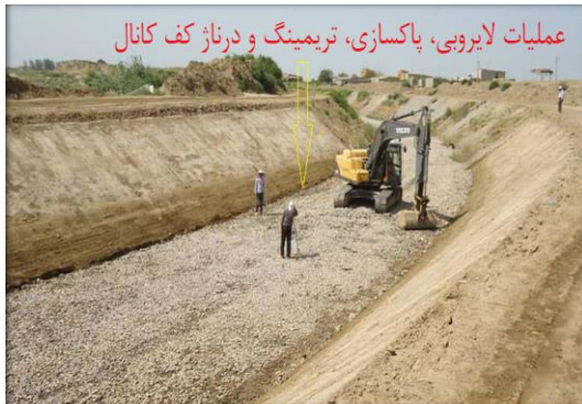
شکل ۶- مراحل عملیات اجرایی ایجاد دایک خاکی، انحراف آب به کانال انحرافی، لایروبی و تریمینگ کانال اصلی مغان به روش کانال انحرافی موقت در حین بهره‌برداری
