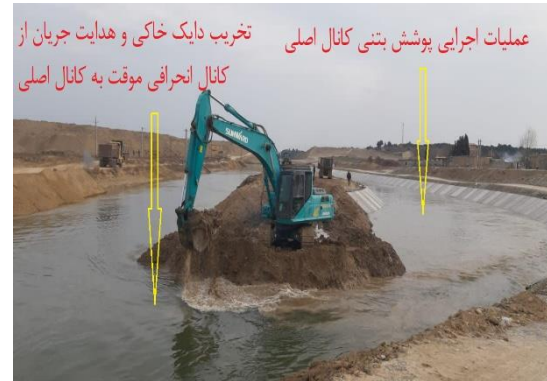
شکل ۶- مراحل عملیات اجرایی ایجاد دایک خاکی، انحراف آب به کانال انحرافی، لایروبی و تریمینگ کانال اصلی مغان به روش کانال انحرافی موقت در حین بهره‌برداری
