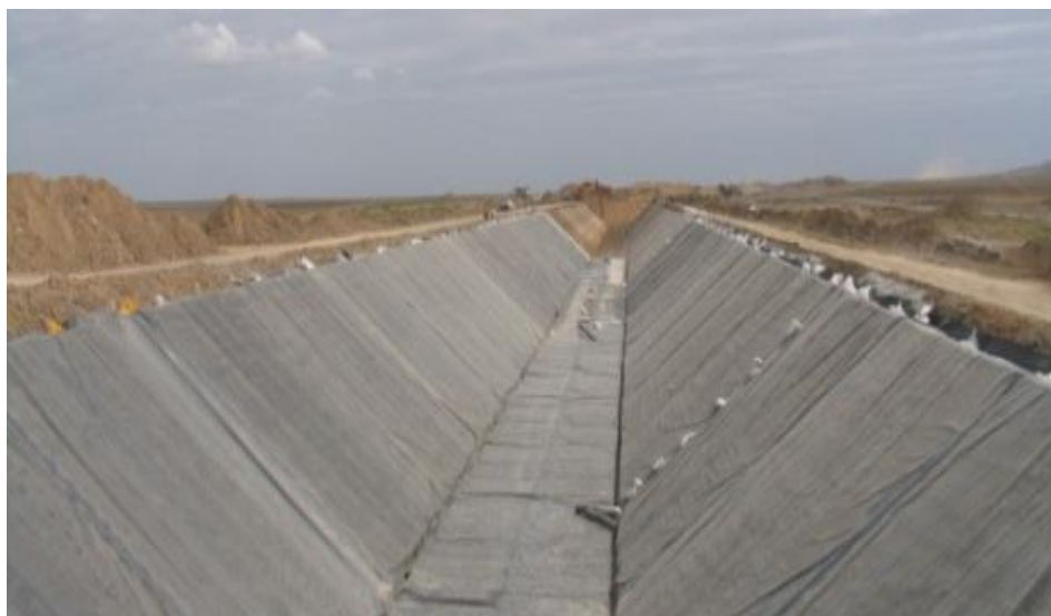
شکل ۷- اجرای پوشش ژئوممبران در کانال‌های شبکه آبیاری مغان.
