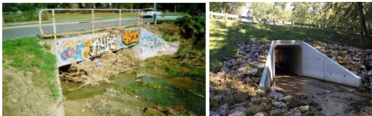
شکل ۱- الف): کالورت در تقاطع با جاده ب): انسداد ورودی کالورت (اقبال و ریاض، ۲۰۲۴)
