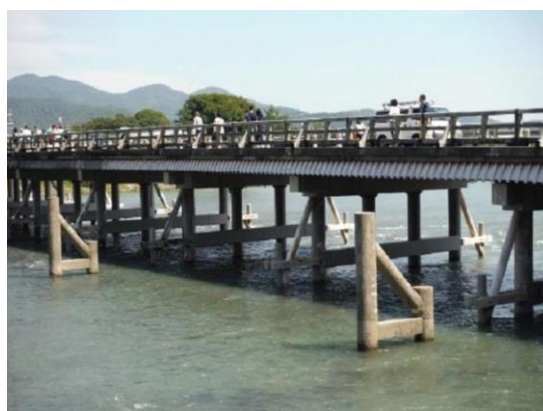
شکل ۲- استفاده از تیرک‌های فولادی هدایت کننده واریزه چوبی پیش از پل‌ها در ژاپن
