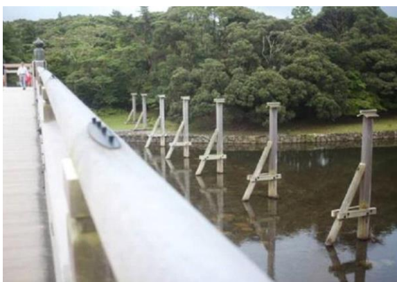
شکل ۲- استفاده از تیرک‌های فولادی هدایت کننده واریزه چوبی پیش از پل‌ها در ژاپن
