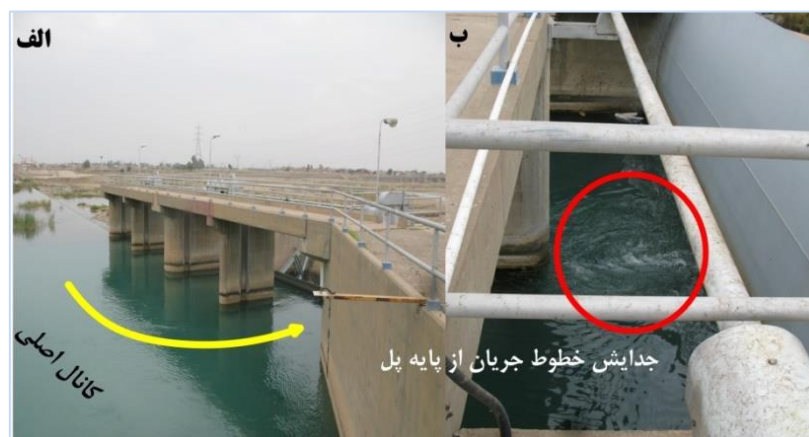
شکل ۱۰- انحناي خطوط جريان و گردابه‌های ناشی از جدايش جريان در بالادست دریاچه قطاعی ورودی کانال W1 دز
