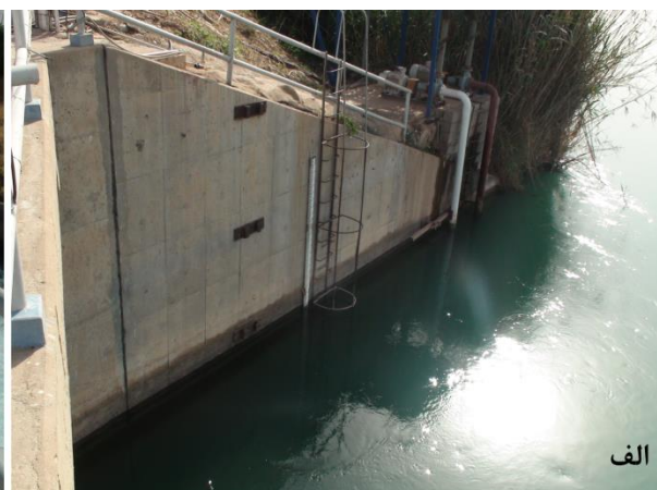
شکل ۴- الف- اشل برای تراز سطح آب در بالادست دريچه قطعی (کانال W1) و ب- گیج قرائت گشودگی دريچه
