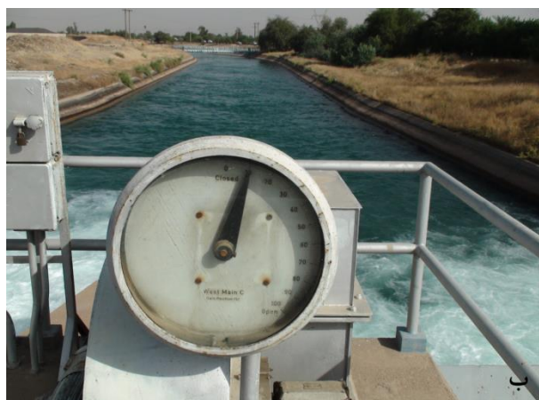
شکل ۴- الف- اشل برای تراز سطح آب در بالادست دريچه قطعی (کانال W1) و ب- گیج قرائت گشودگی دريچه
