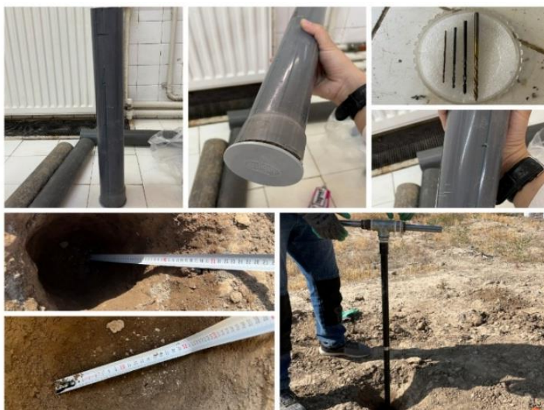
شکل ۱- نمایی از جزئیات فنی استوانه، عملیات حفاری و آماده‌سازی محل نصب
