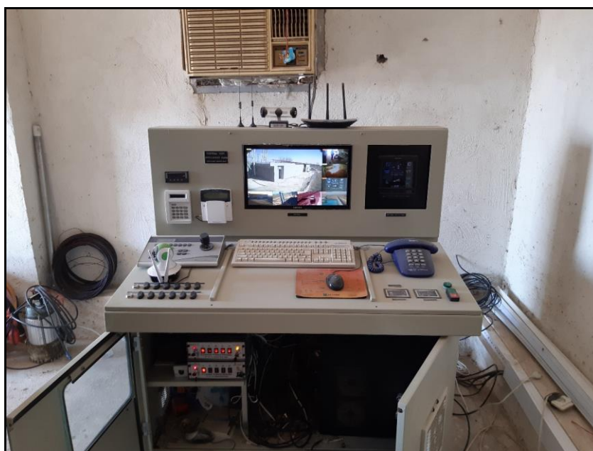
شکل ۹- سامانه آبیاری تجهیز شده به سامانه اسکادا (آبیک- قزوین)
