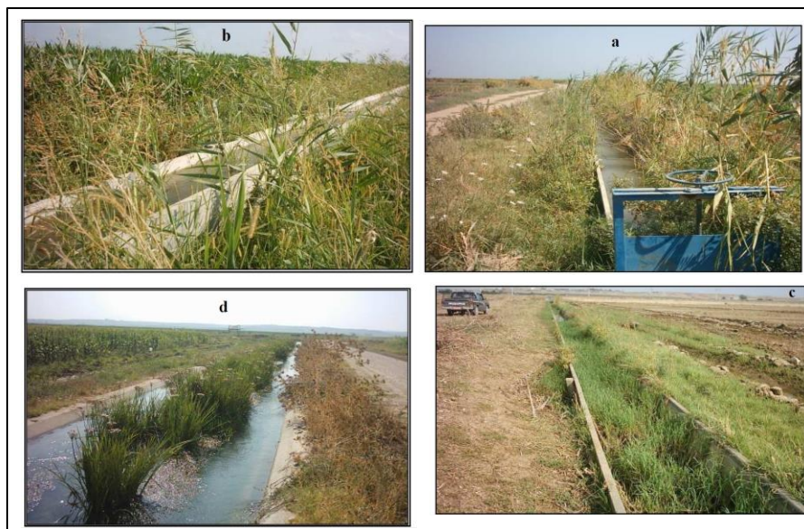
شکل ۶- رشد علف هرز در حریم کانال پیش‌ساخته بتنی (a و b)، در داخل کانال پیش‌ساخته بتنی (c) و کانال درجه ۲ بتنی (d) Fig.6- Weed growth around canalette (a and b), inside canalette (c) and grade 2 concrete canal (d)
