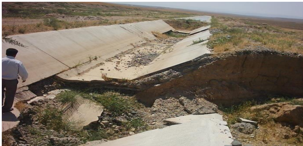
شکل ۲- نمایی از شدت تخریب کانال پمپاژ ۳ در زمان بهره برداری
