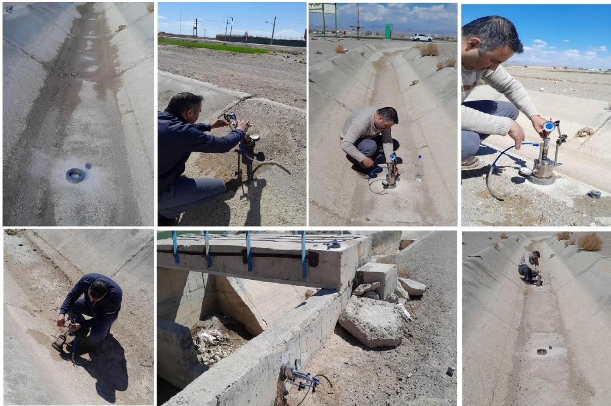
شکل ۶- اجرای آزمون درجای "محفظه استوانه‌ای" روی سازه‌های بتنی موجود
